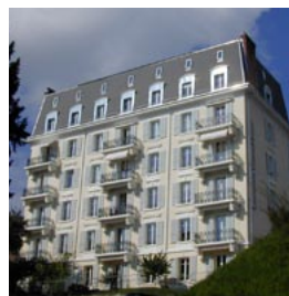
Südfassade des Gebäudes Quelle: Stadt Lausanne
